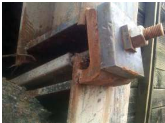
Visualização em detalhe da cabeça de ancoragem.
