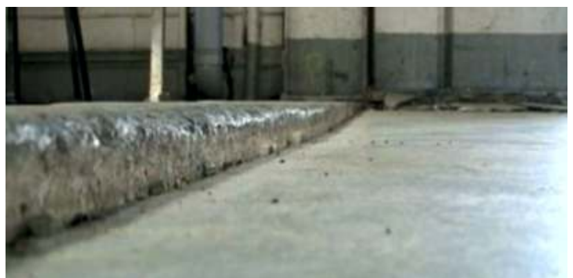
Desnívelamento, entre lajes de piso de concreto armado, construído em região com camadas de solo com baixa capacidade suporte.
