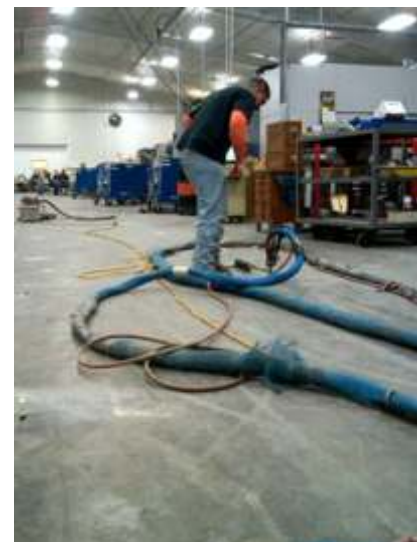
Consolidação do solo sob piso industrial
