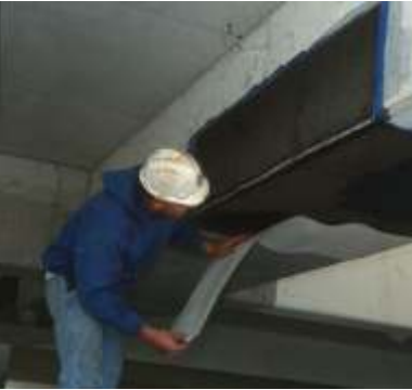
Reforço a flexão e cisalhamento.
