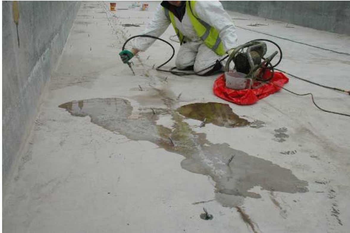
Injeção de resina para recomposição da estrutura.
