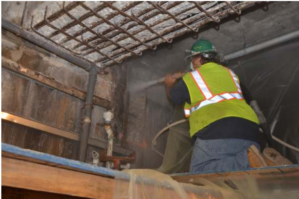
Remoção do concreto solto e deteriorado limpeza das armaduras
