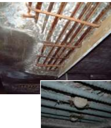
Limpeza das armaduras para instalação da proteção catódica.
