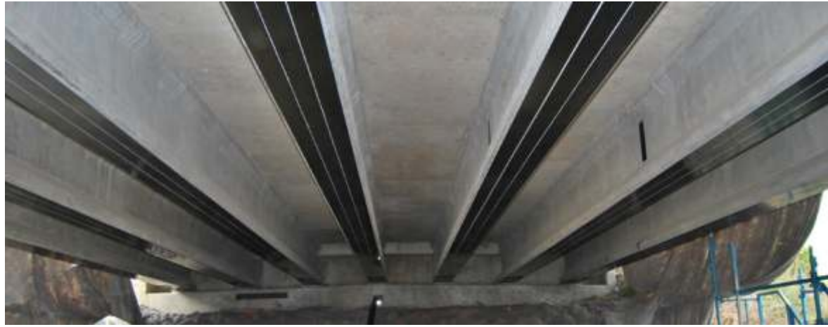
Reforço em estruturas de ponte.
