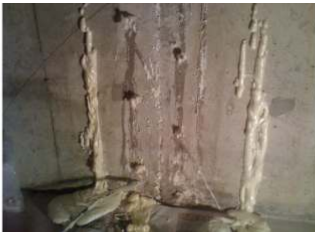
Impermeabilização de parede diafragma em garagem de sub-solo
