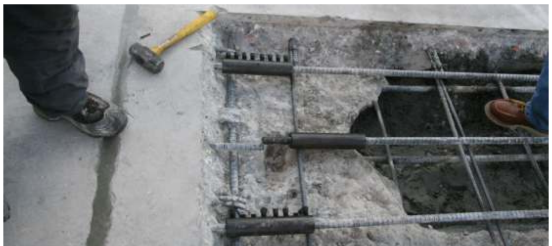
Recomposição das armaduras corroídas.
