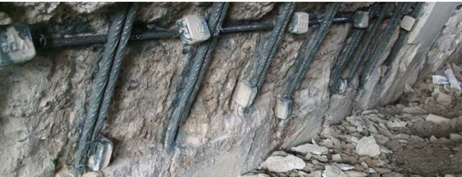
Após a limpeza das armaduras é feita a pintura com zinco líquido, quase 100% de sólidos, e a incorporação de anodos de sacrifício.
