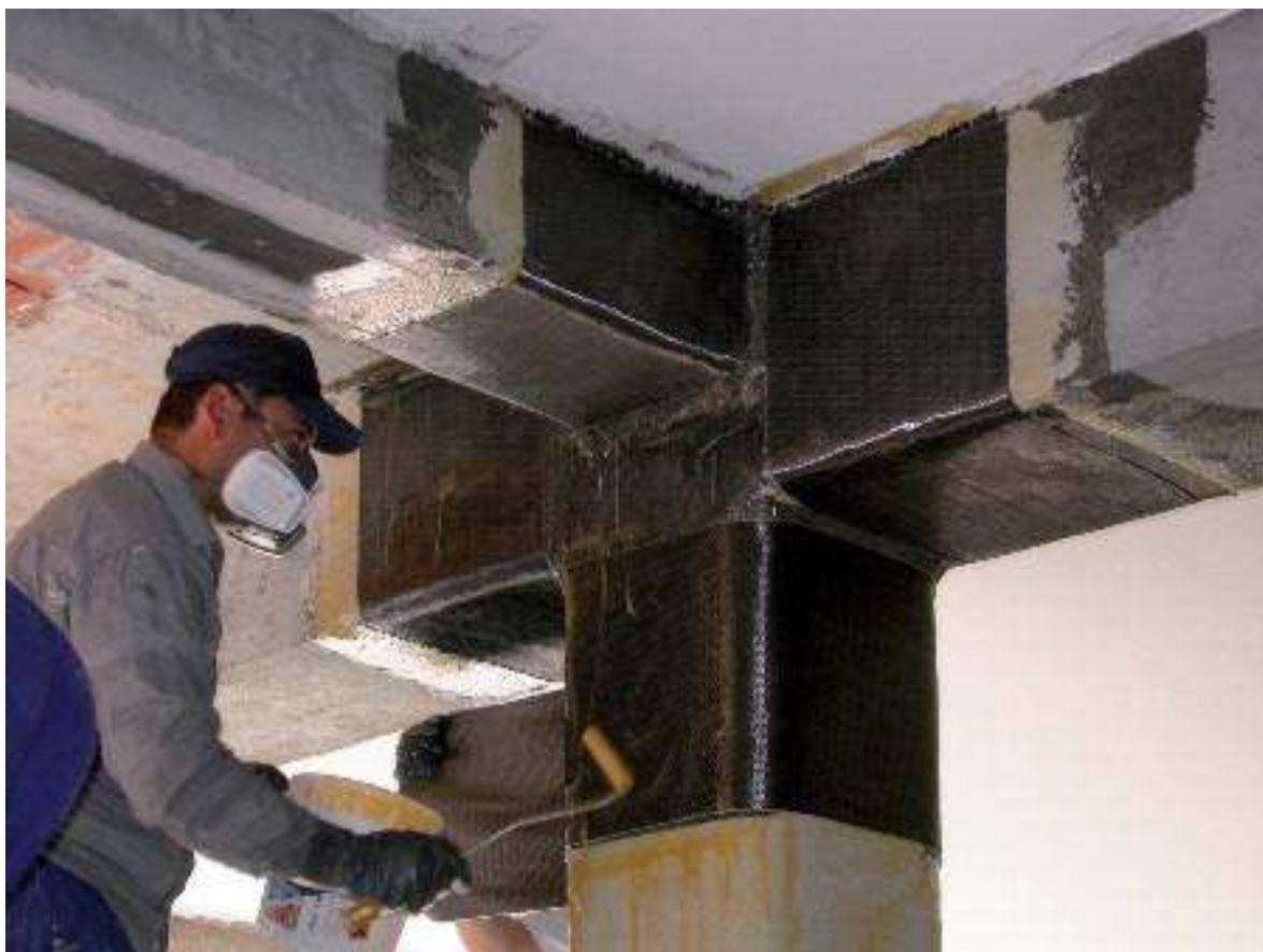
Reforço em encontro de vigas e pilar.
