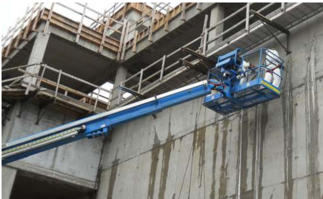
Impermeabilização em Estação de Tratamento de Água
