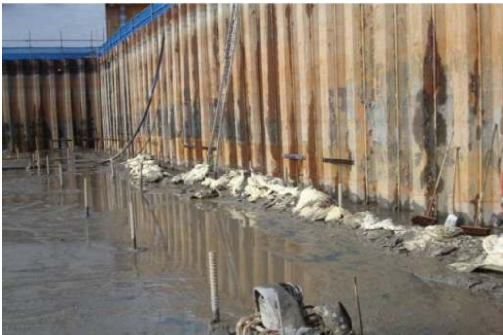
Impermeabilização de parede diafragma em estacas prancha.
