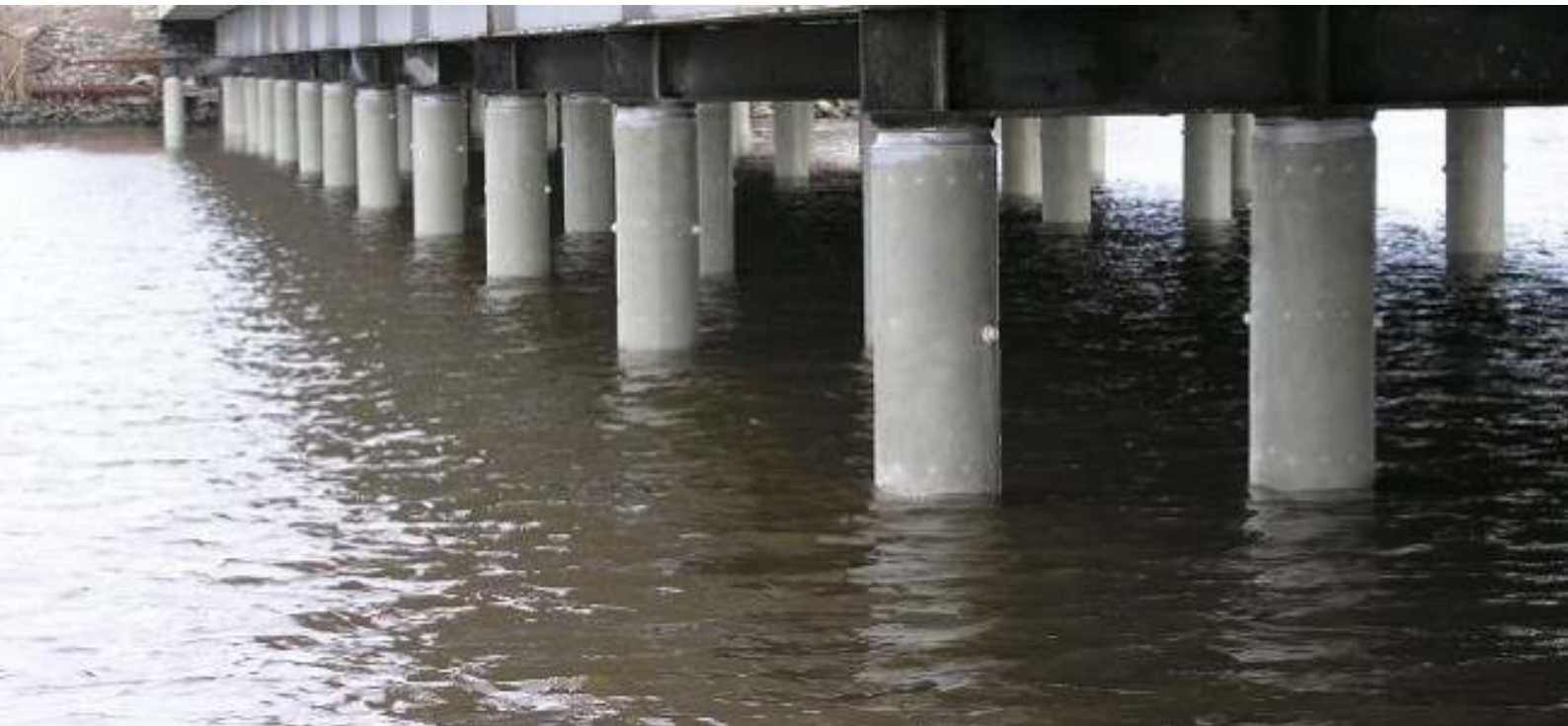
Estacas de concreto protegidas contra corrosão com o sistema de proteção catódica galvânica LifeJacket.
