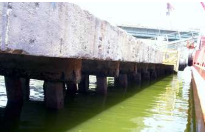
Estacas de concreto protegidas contra corrosão com o sistema de proteção catódica galvânica LifeJacket.
