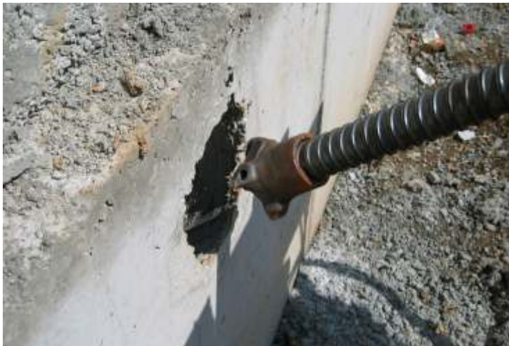
Microestaca com barra autopercutante.
