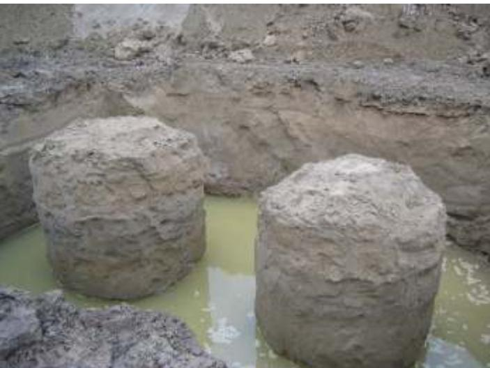
Na estabilidade de taludes é também frequente a realização de cortinas, fazendo as colunas atravessarem a superfície de deslizamento, aumentando a resistência ao cisalhamento.
