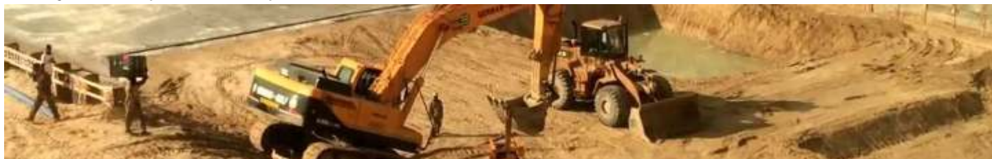
Construção de aterro para encontro de ponte.
