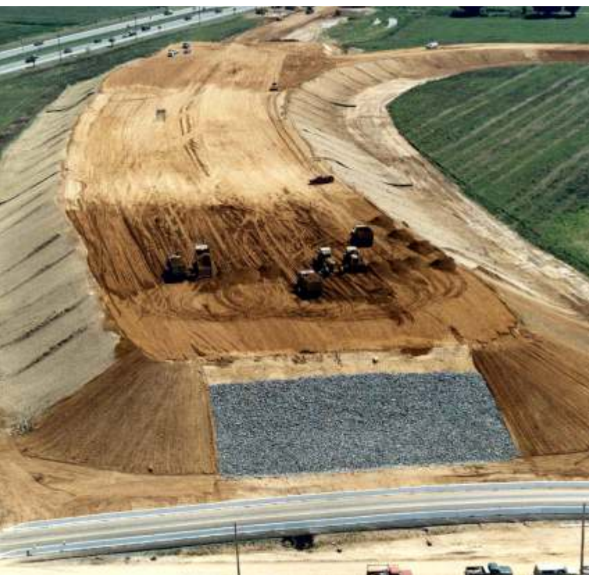
Construção de aterro para encontro de ponte.
