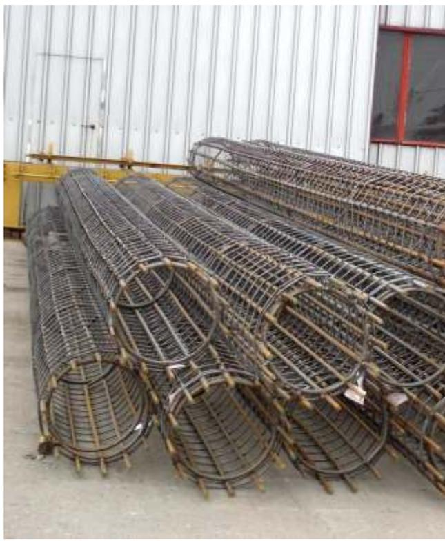
Estaca de pequeno diâmetro moldada "in loco" através da perfuração do solo, com a função de estaca de fundação e cortina de contenção.
