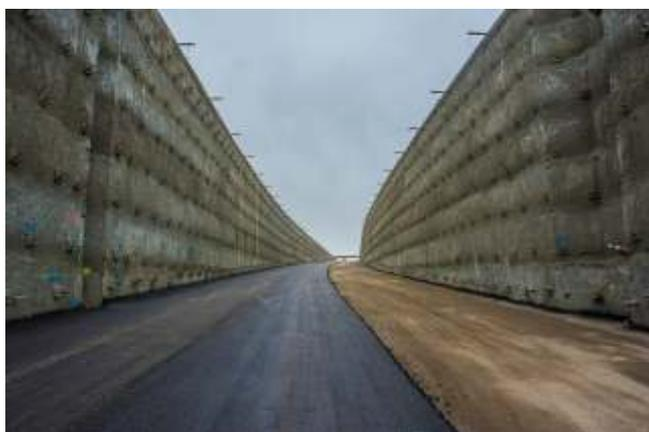
Cortinas Atirantadas tiveram um grande desenvolvimento no Brasil graças ao trabalho incansável do professor A. J. da Costa Nunes, que desenvolveu o método Brasileiro de Atirantamento em 1957. A aplicação deste método segundo o autor é válida para taludes constituídos por solos homogêneos, com superfície de ruptura plana, sem sobrecargas concentradas e de geometria simples.
