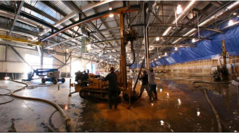
Interrupção de processo de recalques em galpões, reforço do solo de fundação e restabelecimento sua capacidade suporte.
