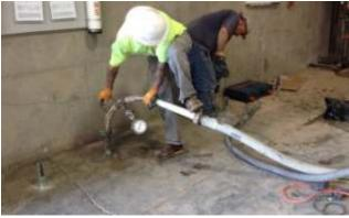
Compaction Grouting Systems (CGS) é uma técnica de melhoramento de solos moles, que tem como objetivo o aumento significativo nas características mecânicas de solos coesivos ou arenosos com presença ou não do lençol freático, através da execução de colunas melhorando o comportamento em geral do solo compósito formado (interação entre solo melhorado e coluna de solo-cimento)..
