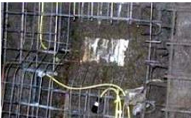
Célula de Pressão Total para determinar a tensão de contato entre o solo e concreto projetado.
